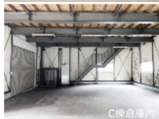
C棟倉庫内
